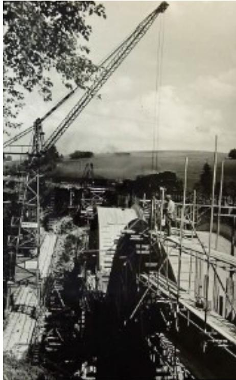
627 - Neubau der Eisenbahnbrücke 1956 parallel zu der von 1895.
