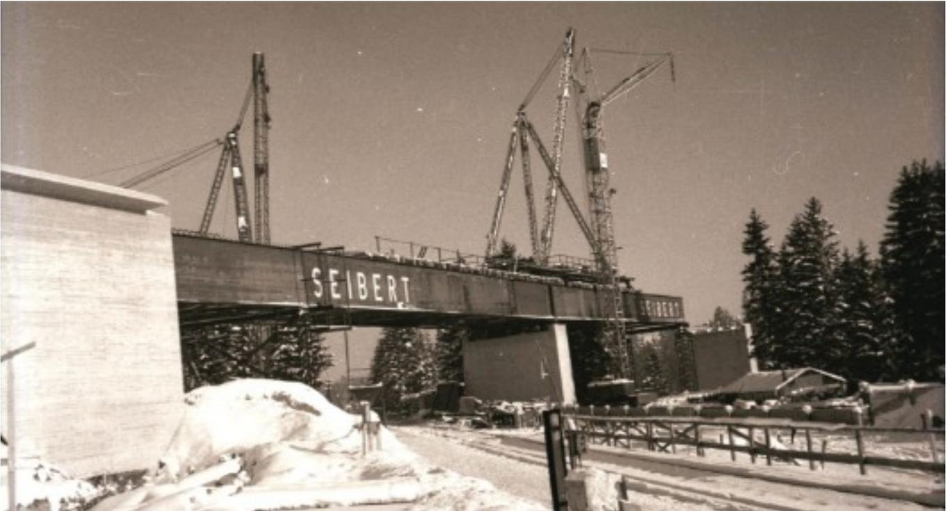
612 - Montage der Stahlträger beim Straßenbrückenbau über die Wertach 1959-1960.
