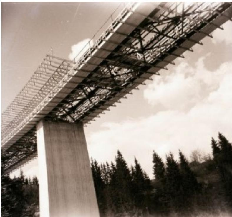
613 - Stahlkonstruktion der Fahrbahn beim Straßenbrückenbau über die Wertach 1959-1960.
