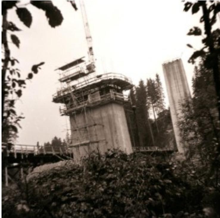
610 - Neubau 1960 der Straßenbrücke über die Wertach an der heutigen Stelle. Die Zugschallung wurde im Baufortschritt mit Hydraulik-Handpumpen nach und nach hochgepumpt.
