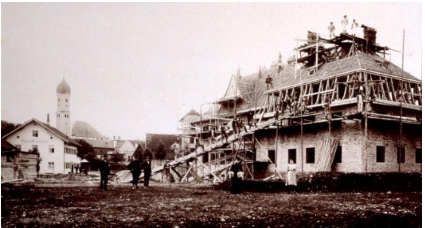
420 - Nesselwang-Schulhausbau 1910 (Architekt Schildhauer) Bei dem Bau hatten die Maurer und Zimmerer noch keinen Kran. Über den Steg musste noch alles per Muskelkraft nach oben befördert werden.
