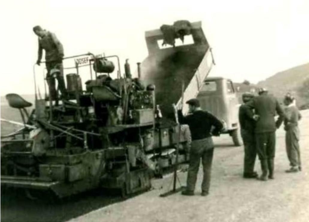
614 - Mit neuartigen Maschinen (Bitufertiger) wurden 1960 die Asphaltsschichten der StraÙendecke für die neue StraÙe über die Wertach bei Gschwend eingebaut.
