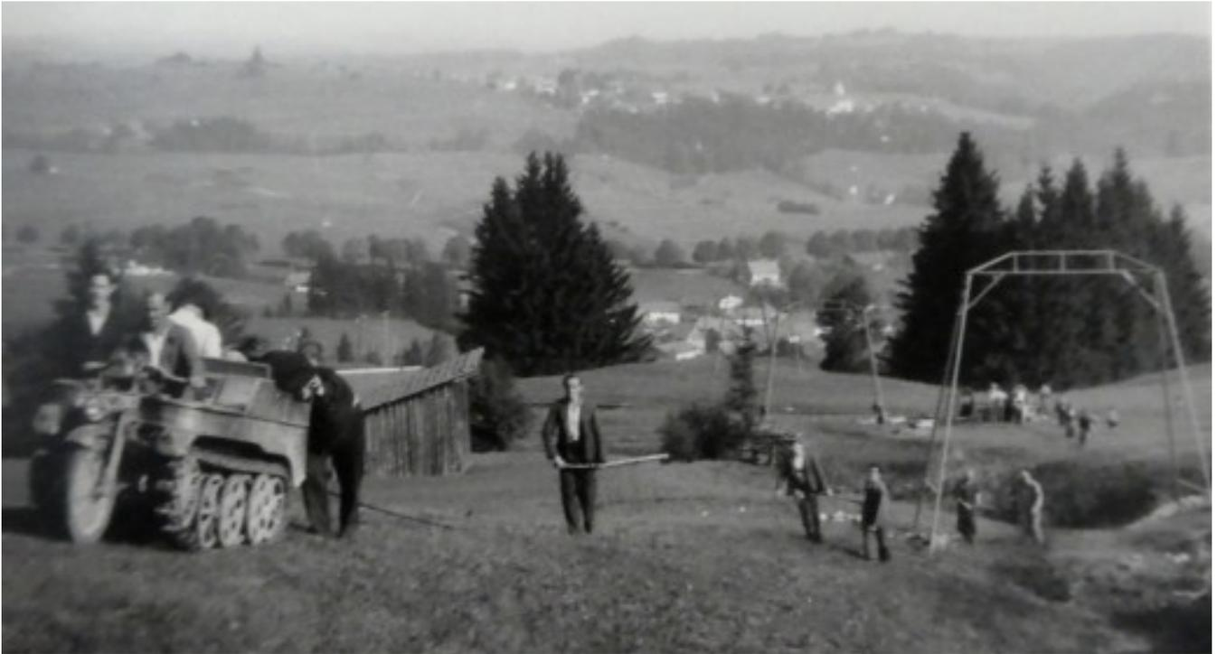
397 - Aufstellen von sog. A-Masten beim Bau des ersten Schwebeliftes an der Alpspitze 1949/50.
